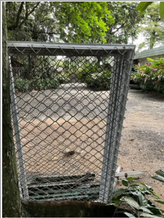
Alte Zäune neu eingesetzt....
